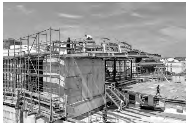
Výstavba na střeše Leopoldova muzea
