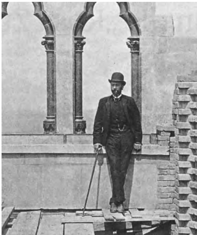
Hrabě Wilczek na stavbě roku 1887
