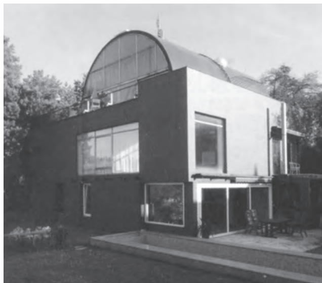
Vlastní vila architektů Pragera a Loudy, Praha 4 – Braník Stavebník a architekt první etapy Karel Prager, stavebník a architekt druhé etapy Jan Louda
