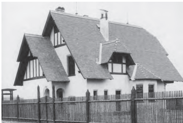
Trmalova vila v Praze 10 – Strašnicích, 1902-1903
