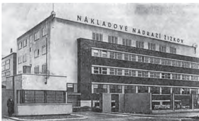
Ve třicátých letech 20. století bylo postaveno v konstruktivistickém stylu nákladové nádraží na Žižkově
