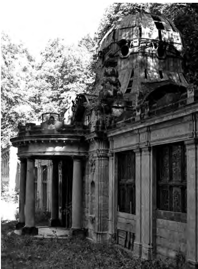
Toto je současný stav kolonády
