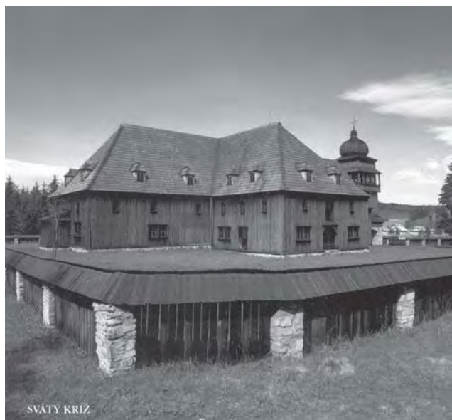
Evangelický kostel Svätý Kríž z let 1773-1774. Patří k největším dřevěným stavbám ve střední Evropě. Přenesen z původního místa a zrestaurován v roce 1982
