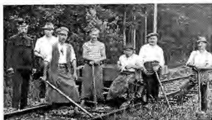
Stavba železnice r.1929
