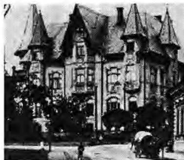
Roeslerova vila v Jablonci - Kokoníně: stav v roce 1910
